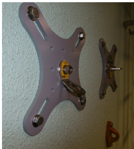
Ejemplo de anclajes estructurales
