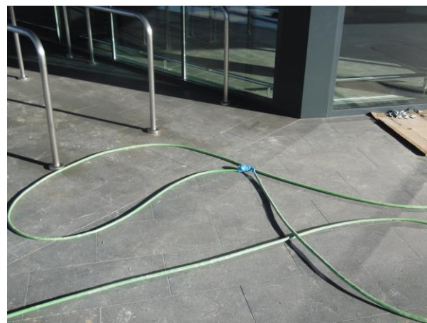
Fig. 3. Cableado eléctrico del grupo electrógeno en zonas de paso
