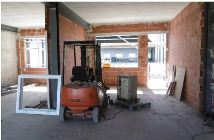
Carretilla eléctrica contrapesada en obra
